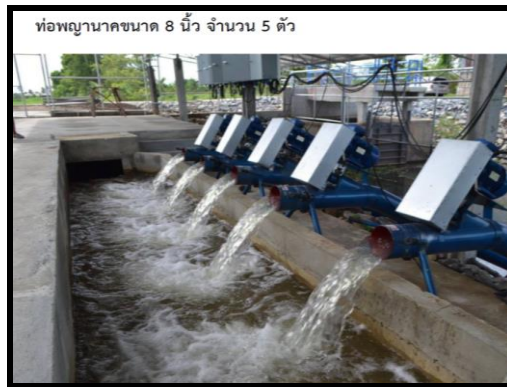
รูปที่ 2 รูปแบบการพัฒนาาระบบกระจายน้ำด้วยพลังงานแสงอาทิตย์ขนาดสูบน้ำไม่น้อยกว่า 1,800 ลูกบาศก์เมตรต่อวัน ที่มา: ผู้วิจัย, 2562
