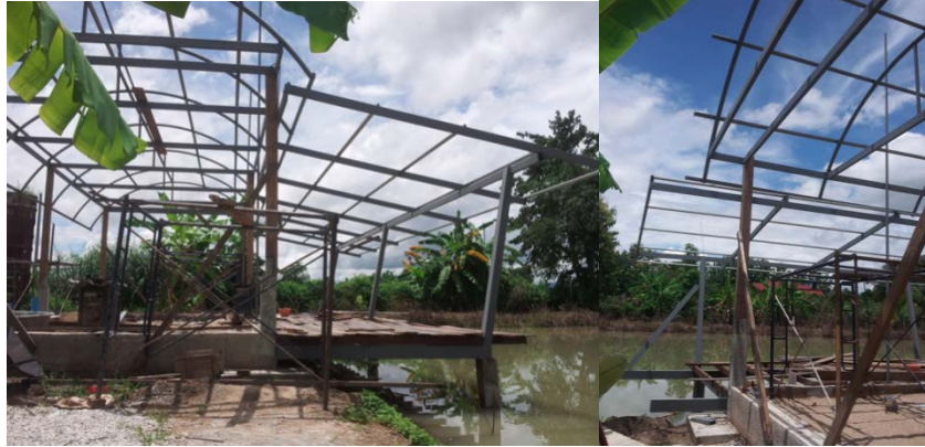
รูปที่ 4 เตรียมโครงสร้างอาคารและ โครงสร้างหลังคา
