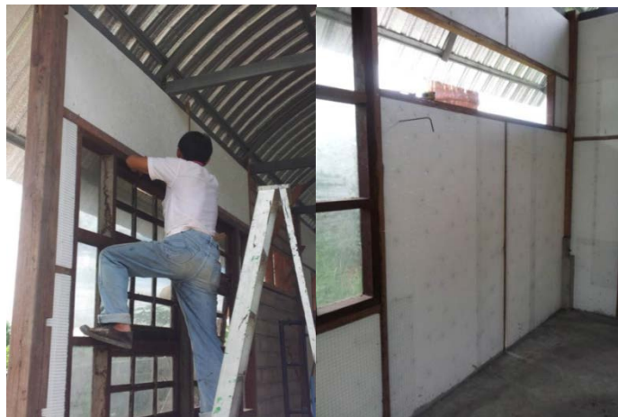
รูปที่ 5 ผนังโฟมกรุวดตะขாயเตรียมฉาบปูนผนังเพื่อปกป้องผิวโฟม
