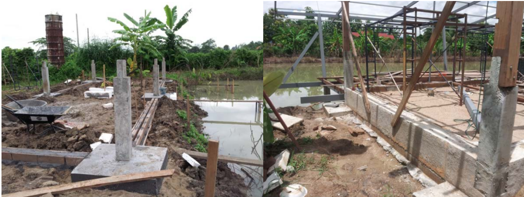
รูปที่ 2 การทำโครงสร้างคานและเสา
