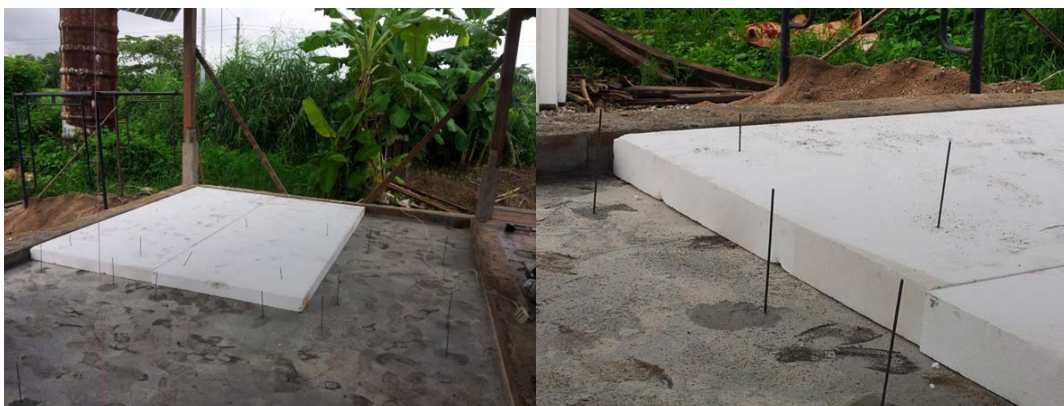
รูปที่ 3 ทำโครงสร้างพื้น ปูด้วยโฟมและเท ค.ส.ล.ทับ
